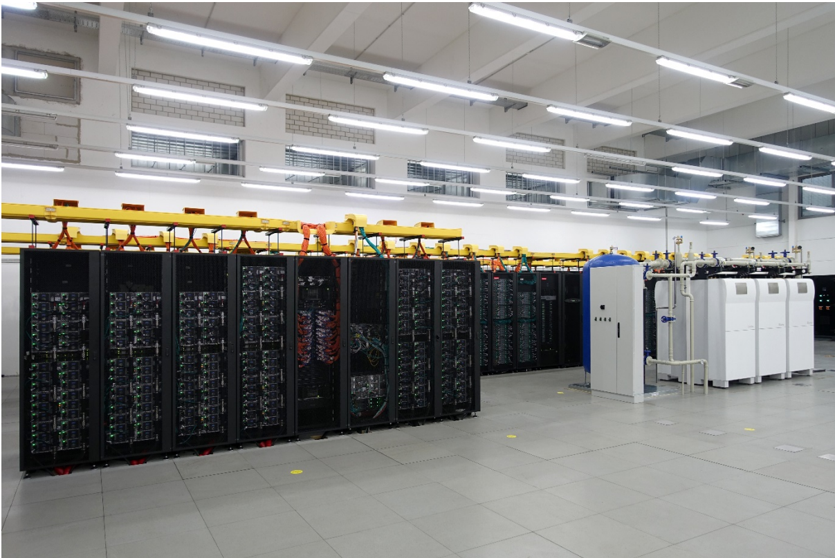
Abbildung 2: CoolMUC-2 Rechnerhardware (links) mit seinen insgesamt 6 Adsorptionskältemaschinen (rechts)
